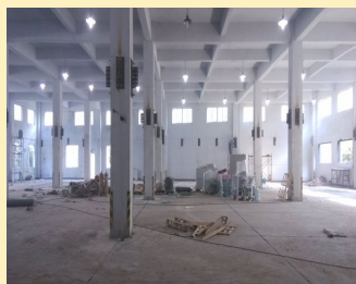
改造中的车间。
